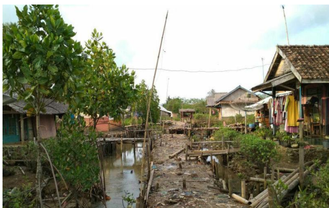
Gambar 1. Kondisi jalan sebelum perbaikan
