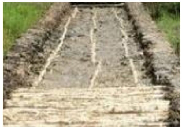
Gambar 4. Pemasangan gelagar kayu galam
