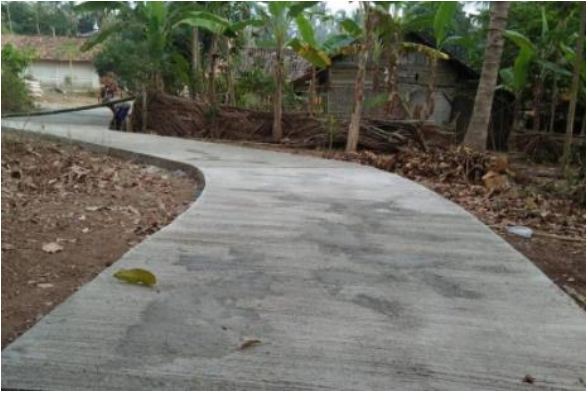
Gambar 6. Kondisi jalan setelah perbaikan
