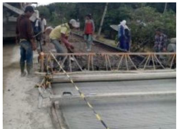
Gambar 5. Pengecoran slab beton jalan
