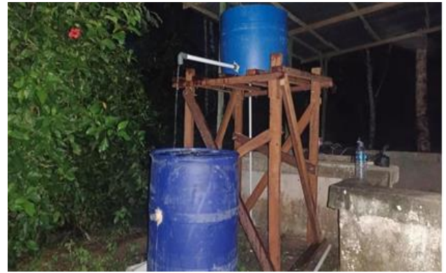
Gambar 9. Sistem Filtrasi yang Terbangun di Mitra
