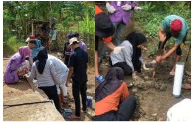
Gambar 7. Penanaman Pipa Biopori di Setiap Dusun Desa Molingkapoto
