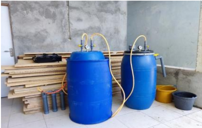
Gambar 6. Pemasangan Alat Instalasi Biogas di Lokasi PkM
