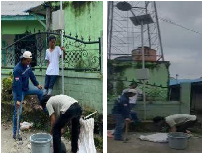
Gambar 4. Pemasangan lampu penerangan jalan berbasis panel surya di lokasi 1
