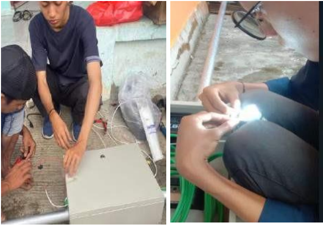
Gambar 3. Uji coba lampu penerangan jalan
