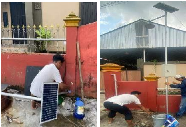
Gambar 5. Pemasangan lampu penerangan jalan berbasis panel surya di lokasi 2
