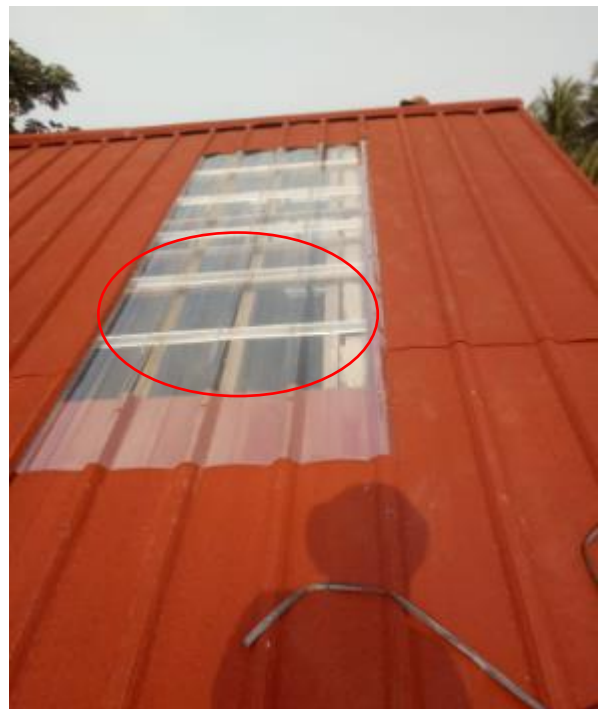
Gambar 5(b). Proses Pemasangan Skylight
