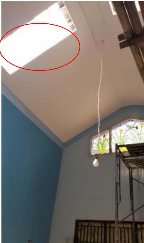
Gambar 6. Suasana ruangan setelah terpasangnya atap skylight
