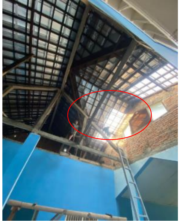
Gambar 5(a). Proses Pemasangan Skylight
