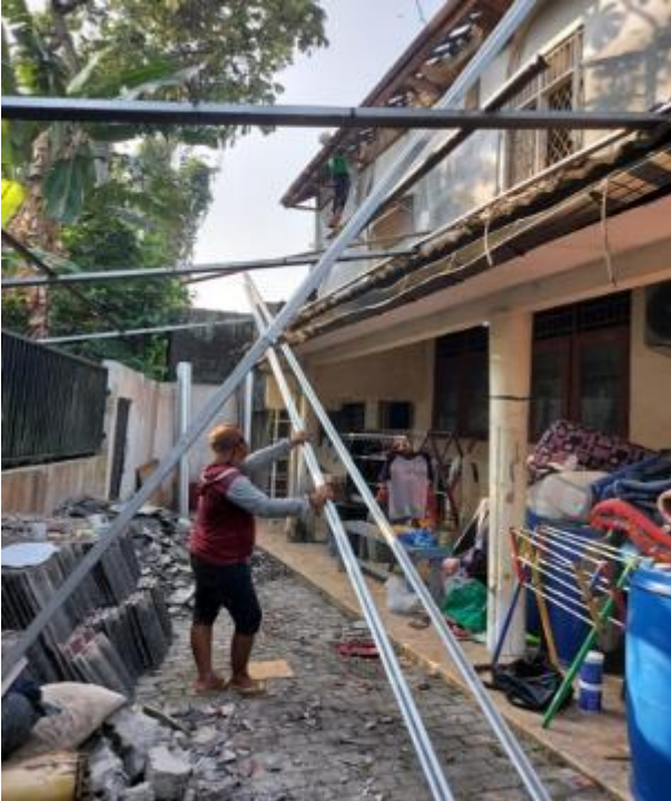
Gambar 3: Bahan-bahan yang digunakan dalam pemasangan skylight
