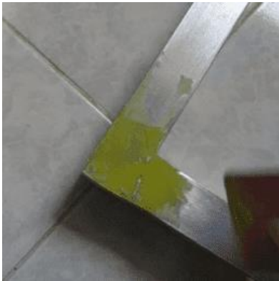
Gambar 10. Proses Pendempulan Rangka Galvanis
