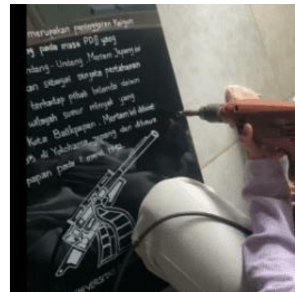
Gambar 13. Pemasangan Akrilik pada Rangka Galvanis dengan Baut Baja Ringan
