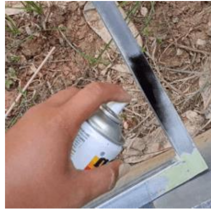
Gambar 12. Proses Pengecatan Rangka Galvanis
