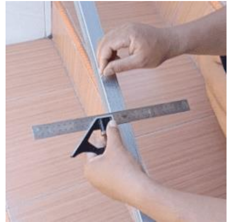
Gambar 6. Pengukuran Rangka Galvanis
