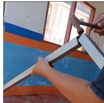
Gambar 8. Pembentukan Rangka Galvanis
