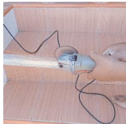
Gambar 7. Pemotongan Rangka Galvanis
