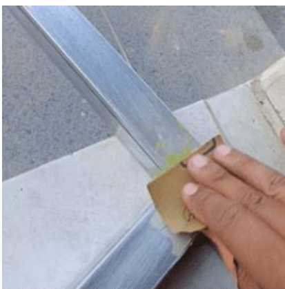
Gambar 11. Proses Ampelas Rangka Galvanis
