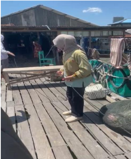
Gambar 9. Proses penarikan kabel
