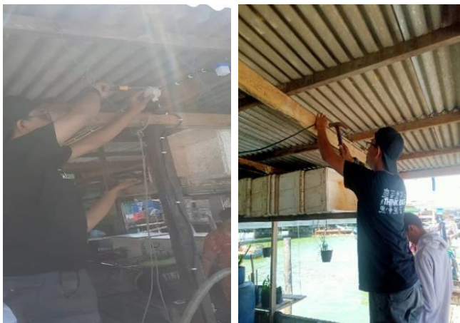
Gambar 10. Proses instalasi Sensor Cahaya (Photocell) dan Perapian Kabel
