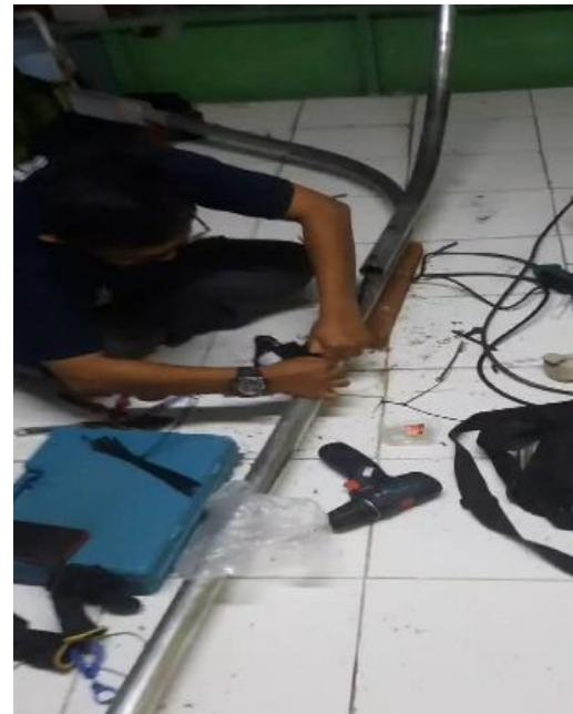
Gambar 6. Proses pemasangan sensor gerak
