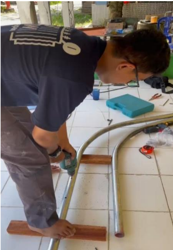
Gambar 5. Proses pembuatan lubang untuk dudukan lampu kedua
