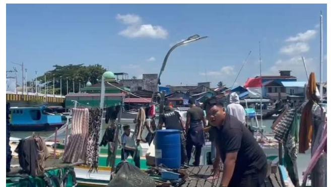
Gambar 8. Proses pendirian tiang lampu
