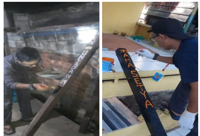
Gambar 7. Proses pengecatan kayu balok ulin 8×8 cm
