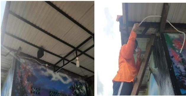
**Gambar 6. Pemasangan Sensor Cahaya (*Photocell*) pada Instalasi Penerangan**
