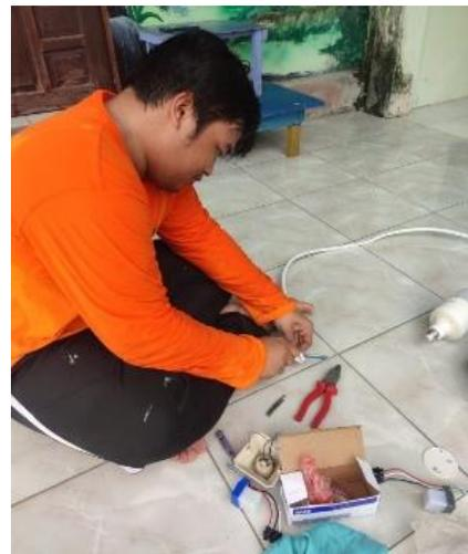
Gambar 4. Proses Perakitan Sensor *Photocell* untuk di-*install* di Instalasi Penerangan SD Adz Dzikru
